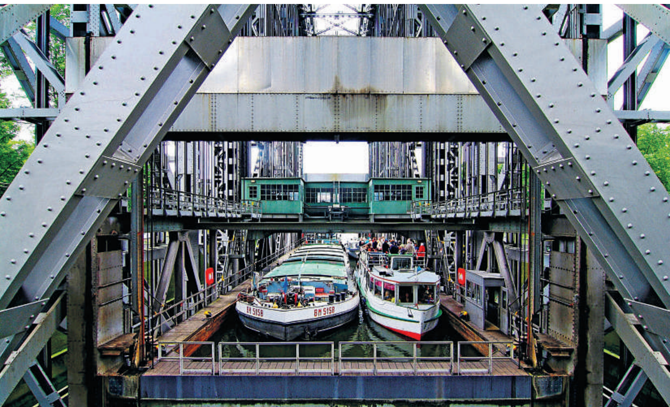
Schiffe, die von der Havel in die Oder gelangen wollen, müssen einen Höhenunterschied von 36 Metern überwinden. Möglich macht dies das Schiffshebewerk Niederfinow.
